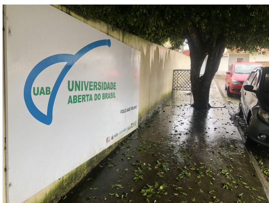
FACHADA DO POLO
