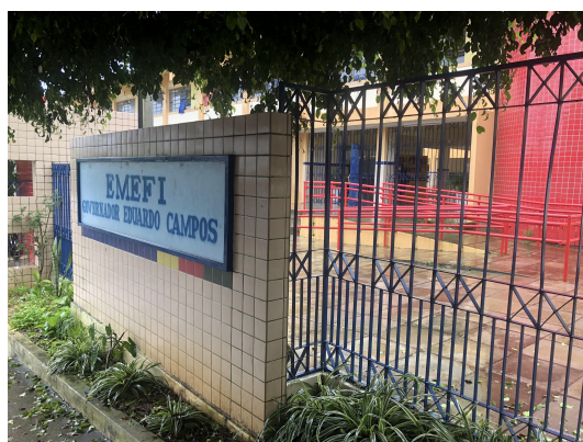
FACHADA DA EMEFI GOV. EDUARDO CAMPOS
